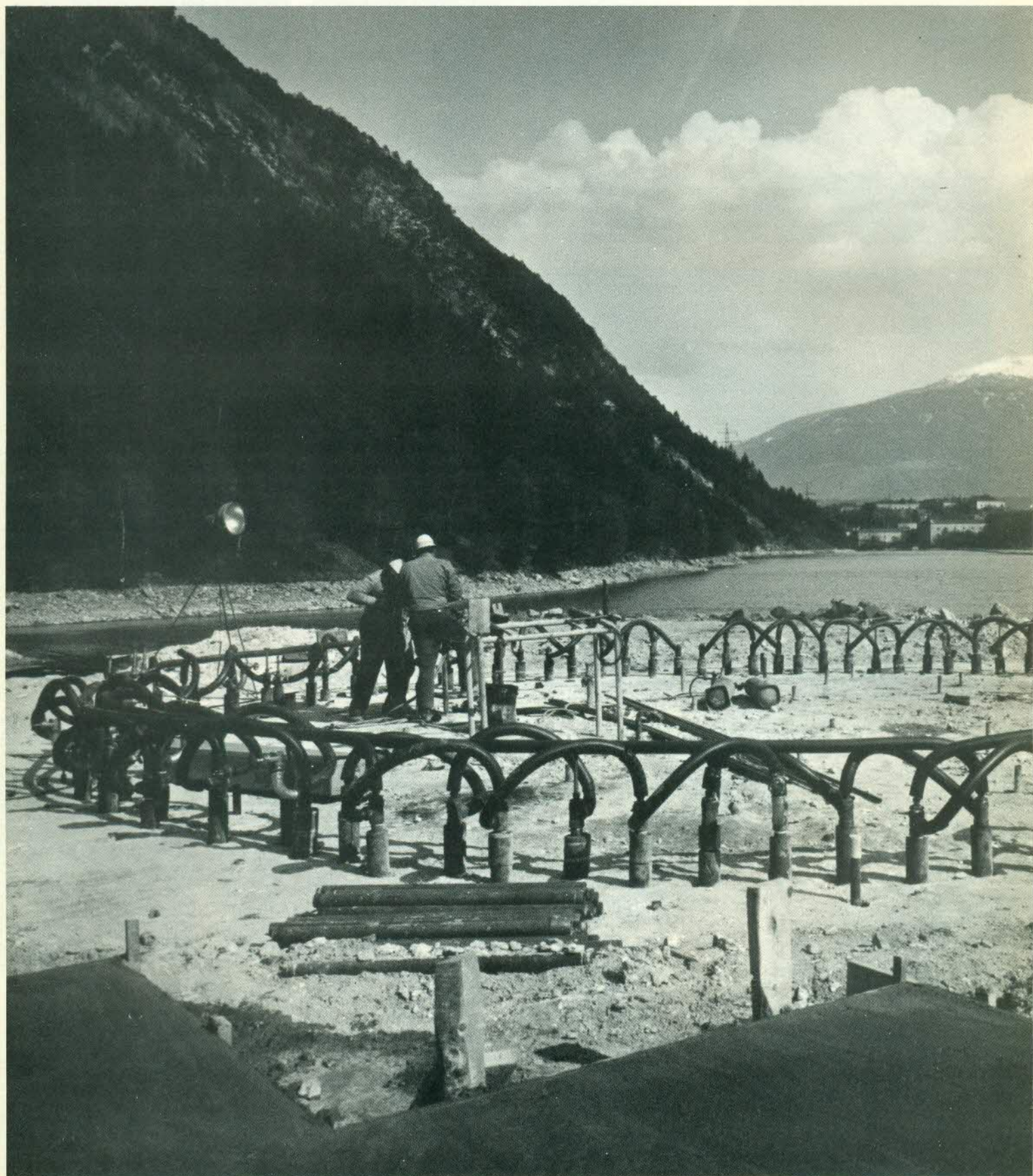
Il grande anello circolare della pila n° 5 in fase di montaggio
