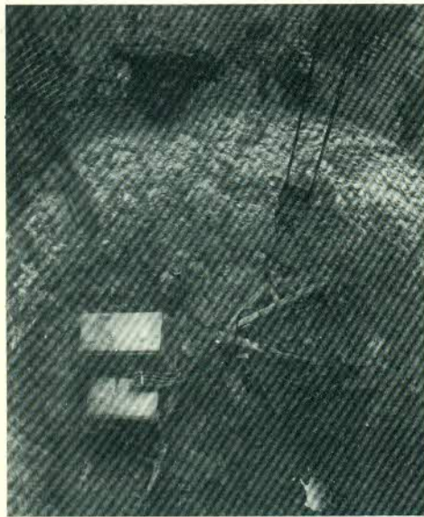
Fig. 4 e 5 - Pozzi in fase di scavo sotto falda dopo congelamento. Si possono notare i grossi ciottoli che hanno ostacolato non poco le operazioni di perforazione. La tenuta della parete congelata è risultata ottima □ Wells under excavation after freezing. The big boulders, which gave some problems to drilling operations, can be seen. The watertightness of the walls was always successful
