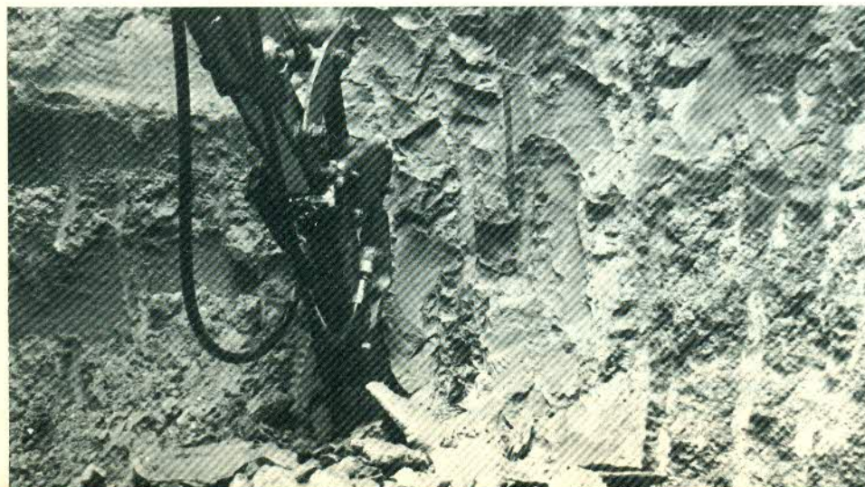
Fig. 4 e 5 - Pozzi in fase di scavo sotto falda dopo congelamento. Si possono notare i grossi ciottoli che hanno ostacolato non poco le operazioni di perforazione. La tenuta della parete congelata è risultata ottima □ Wells under excavation after freezing. The big boulders, which gave some problems to drilling operations, can be seen. The watertightness of the walls was always successful
