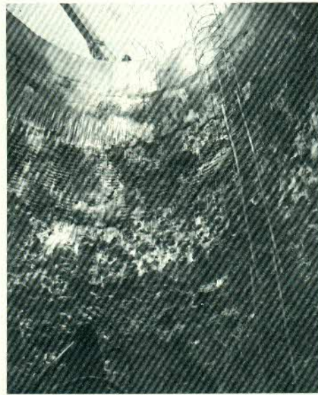
Fig. 4 e 5 - Pozzi in fase di scavo sotto falda dopo congelamento. Si possono notare i grossi ciottoli che hanno ostacolato non poco le operazioni di perforazione. La tenuta della parete congelata è risultata ottima □ Wells under excavation after freezing. The big boulders, which gave some problems to drilling operations, can be seen. The watertightness of the walls was always successful
