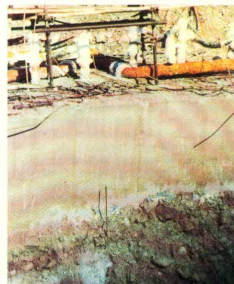
Fig. 12 - Il punto più delicato del congelamento, alla base degli anelli di rivestimento in c.a. Si notano i grossi blocchi ed il terreno «rilassato» a causa dei precedenti pompaggi □ The most delicate point of freezing, at the bottom of concrete lining rings. Big boulders and loose soil because of previous pumping can be noticed
