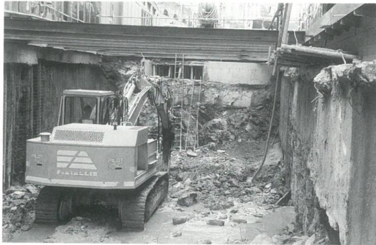
Fig. 8 Sezione di scavo per la galleria a cielo aperto in via S. Benedetto. Sullo sfondo è visibile il fronte d'attacco della galleria a foro cieco.
