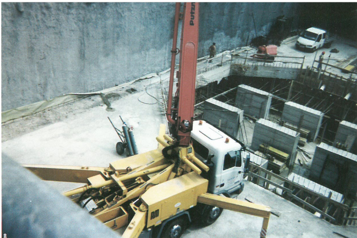
8. Vista della vasca di aggotamento; si notano i diaframmi con i tiranti in testa e la struttura in c.a. di contrasto. Al centro i pilastri di sostegno dell'impalcato stradale.
