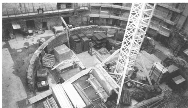
Foto 2 - Vista della Sala Teatrale ad inizio lavori
