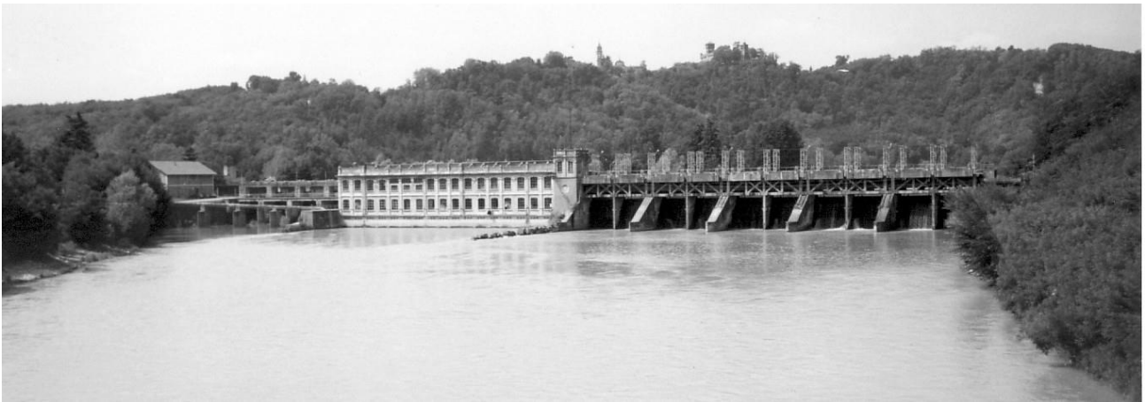
FIGURA 1. Vista da valle della traversa di Mazzè. In sinistra orografica si possono osservare gli speroni della traversa ed i setti intermedi, che dividono lo sbarramento in dieci luci, regolate da paratoie piane.
